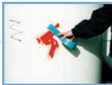
ガムテープを落書き部分に貼る。
