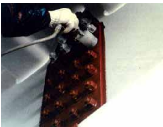
カップ塗装作業状況
