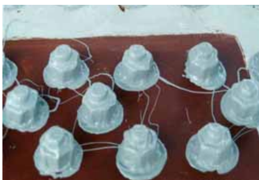
カップ注入塗装後、余分な塗料はハケで均し塗装する。
