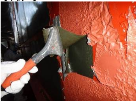
手工具による塗膜はく離作業状況
