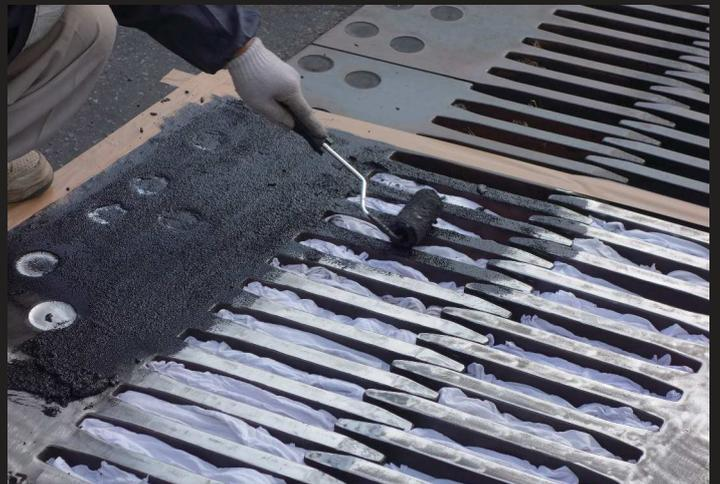
「G-MAX(ジーマックス)」とは、2液性常温硬化エポキシ樹脂をベースに、耐摩耗性に優れる骨材を均一に添加した滑り止めコート材です。
